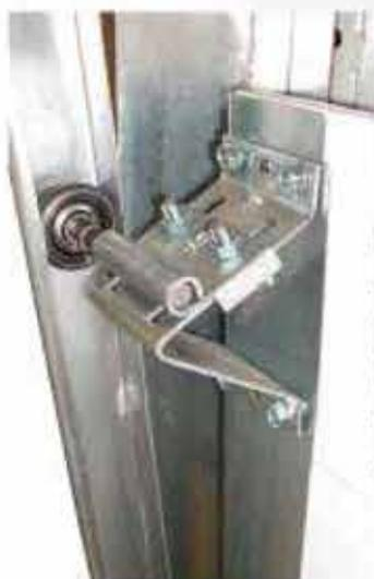
Las bisagras portan rodillos que se desplazan en las guías laterales permitiendo así la elevación de los paneles
