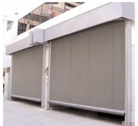
Edificio de estacionamiento
